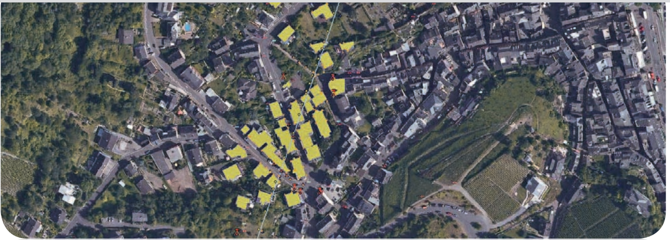
■ Der Tunnel unterquert zahlreiche Häuser im Stadtgebiet von Cochem, teilweise mit nur drei Metern Überdeckung.
