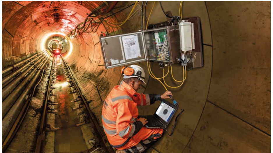
Die Glasfaser-Backbone-Installation wird eingerichtet und überprüft.
